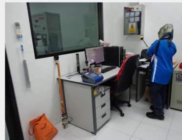
Pengukuran radiasi elektromagnetik (non-pengion) di dekat panel listrik
